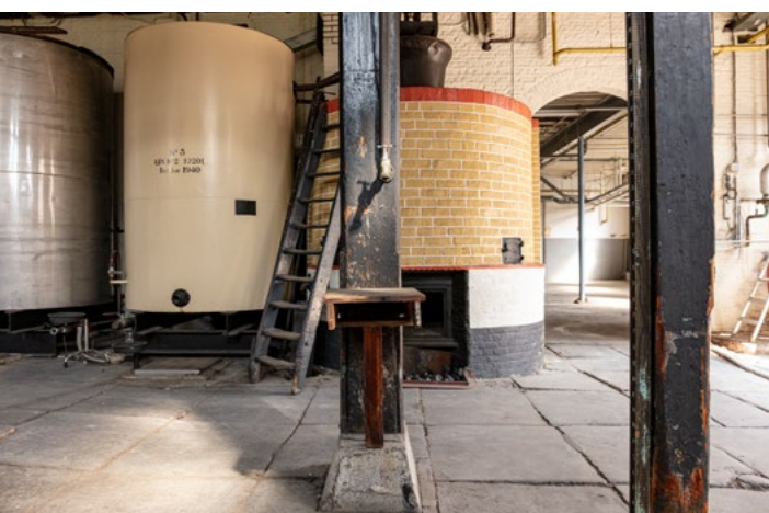
Interieur van voormalige branderij op Dirckzwagerterrein
