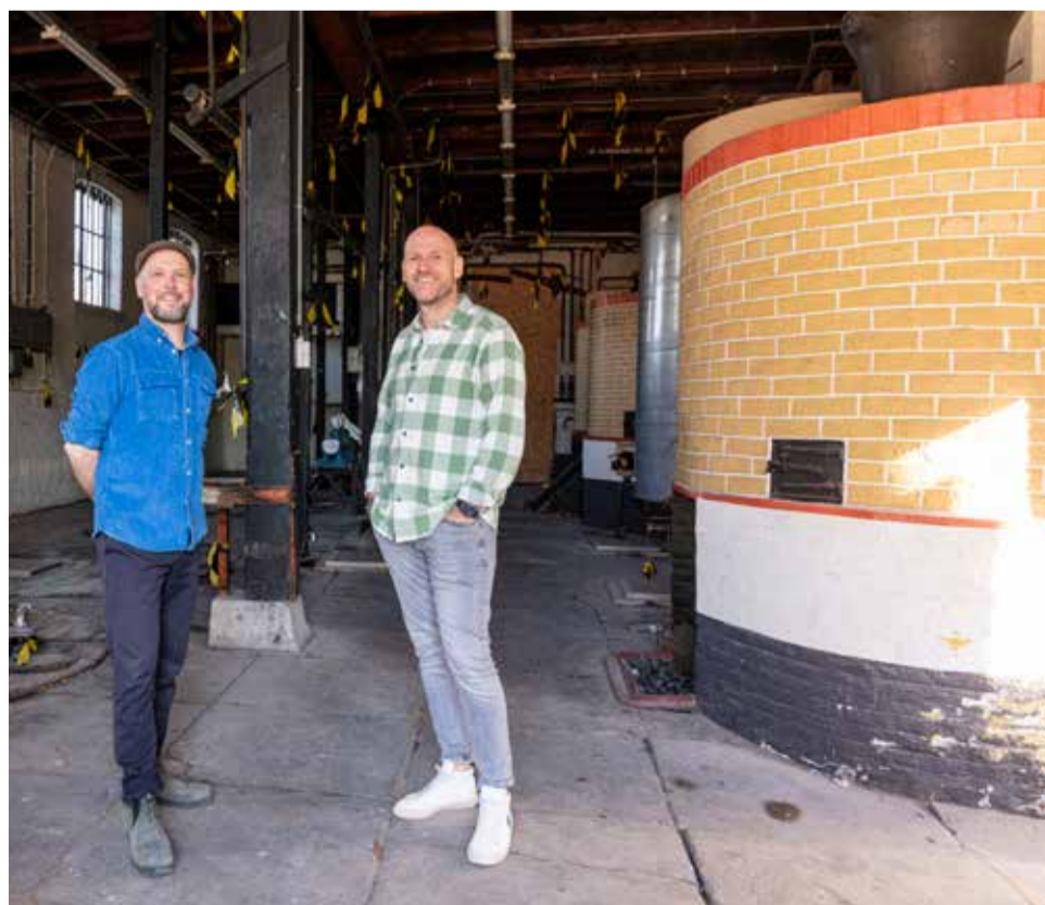
De voormalige ketels blijven behouden en staan straks in restaurant ROOK.
